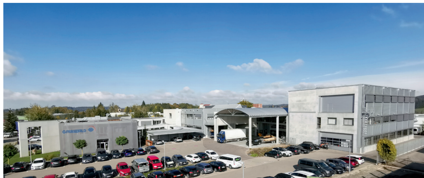
Das Foto zeigt den Blick über das GRUNWALD-Betriebsgelände, aufgenommen vom oberen Parkdeck unseres vor kurzem fertig gestellten Parkhauses.
